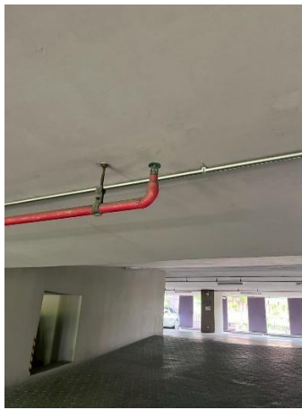
ภาพที่ 29 ระบบดับเพลิงแบบกระจายกระจายน้ำอัตโนมัติ
