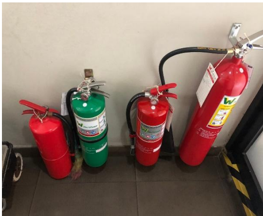
ภาพที่ 30 เครื่องดับเพลิงแบบมือถือ และการตรวจสอบ
