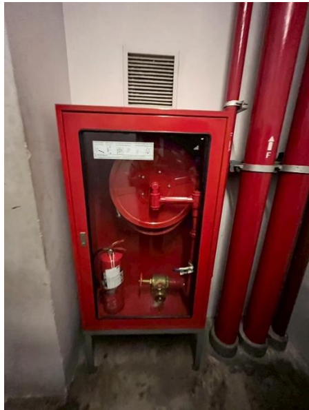
ภาพที่ 27 ตู้สายฉีดน้ำดับเพลิง
