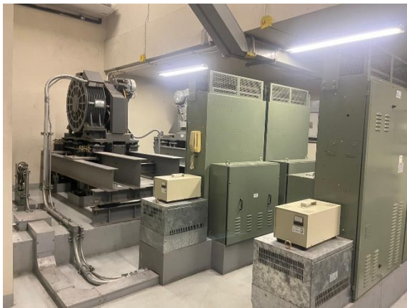
ภาพที่ 33 ระบบจ่ายไฟฟ้าสำรอง
