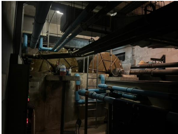
ภาพที่ 7 ระบบบำบัดน้ำเสียแบบ RBC
