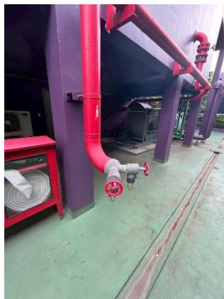
ภาพที่ 28 น้ำสำรองสำหรับดับเพลิงและหัวรับน้ำดับเพลิง
